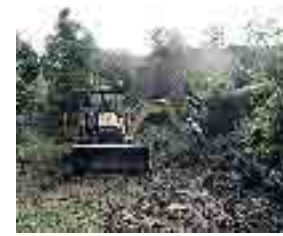
FERRIERE - I lavori in corso per realizzare la passeggiata
